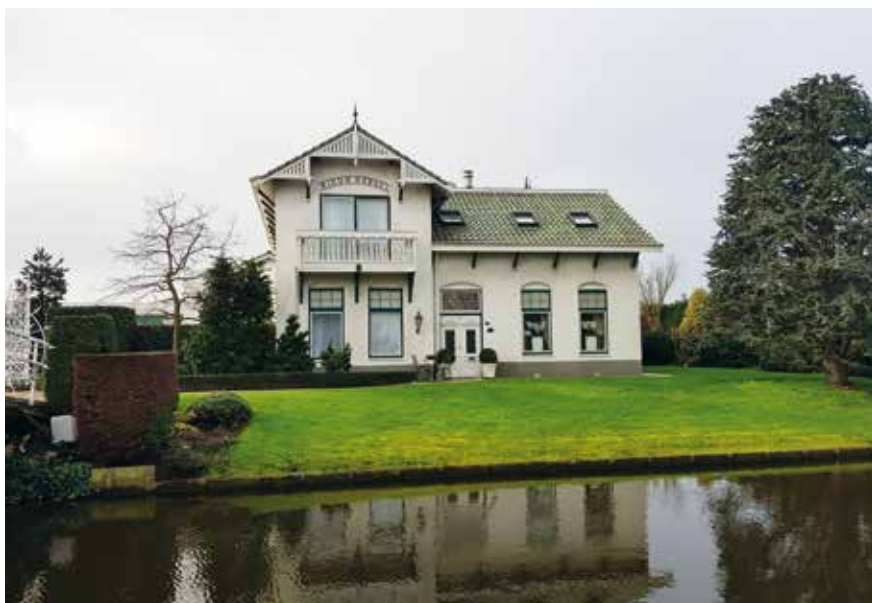
De bedrijfswoning van Nieuw-Honsel, vlak voor de sloop in 2020. Foto Gustaaf van Gaalen.
