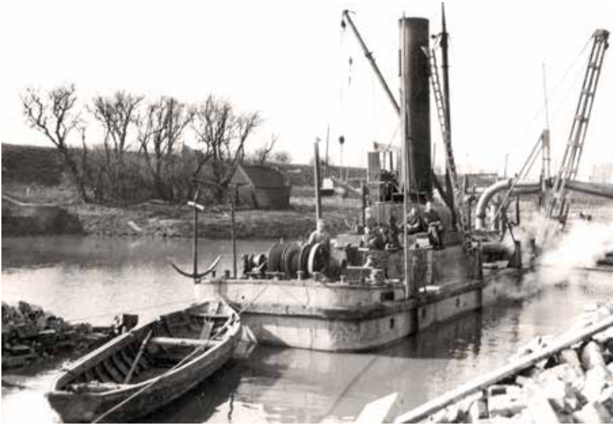
Een zandzuiger in actie bij de aanleg van de tankgracht. Links de kleine Oranjesluis. Foto: Wim van den Ende. Collectie familie Van den Ende.
