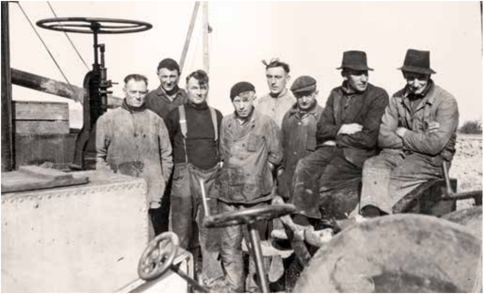
Ploeg werknemers bij de aanleg van de tankgracht. Foto: Wim van den Ende. Collectie familie Van den Ende.
