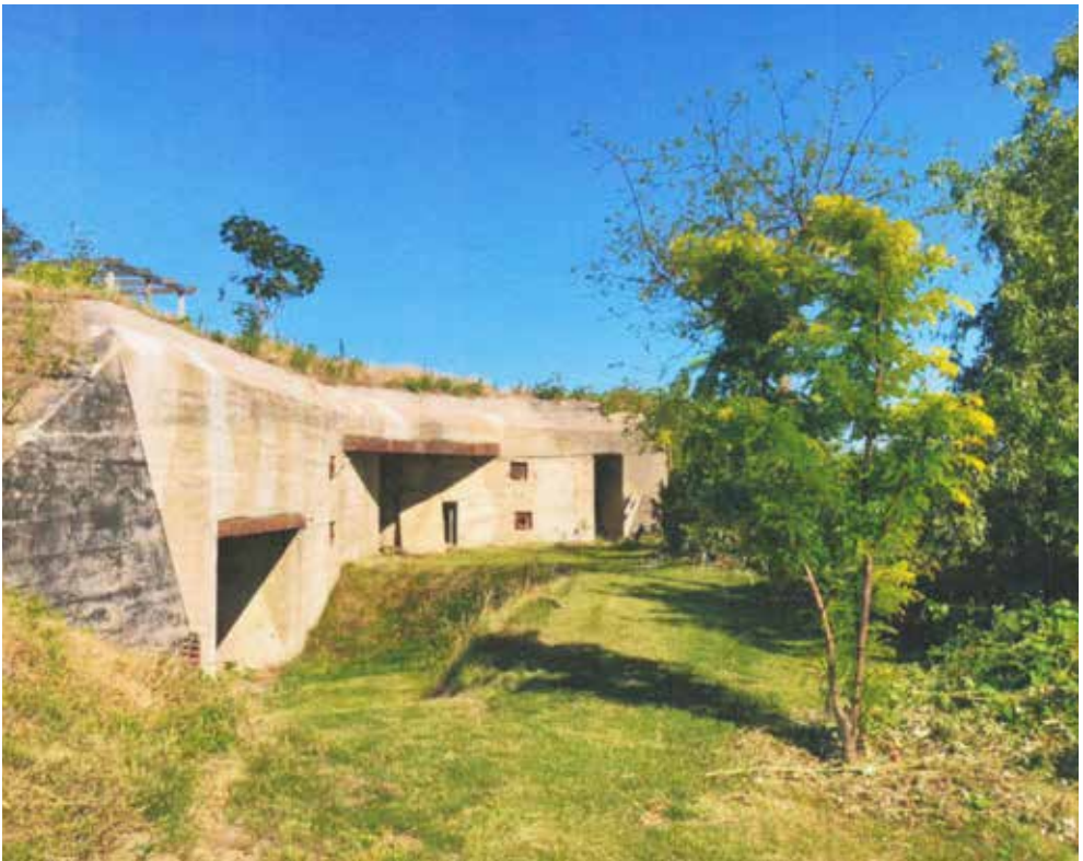
Een van de zes bunkers bij de Sperre Waalbrug die na de oorlog is uitgraven. Collectie Peter de Krom.
