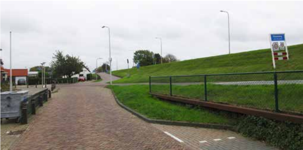
De Heenweg met opritten naar de Maasdijk.
