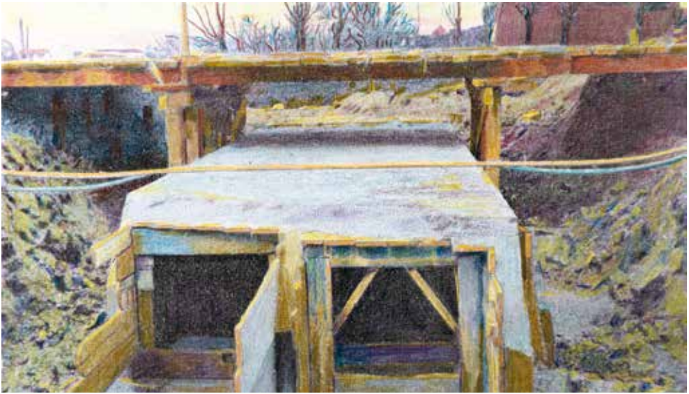
Voorbeeld van een duiker in aanleg, 1929. Rapport Provinciale Waterstaat in Zuid-Holland. Fotobewerking: auteur. Foto: Ron Nieuwenhuizen.
