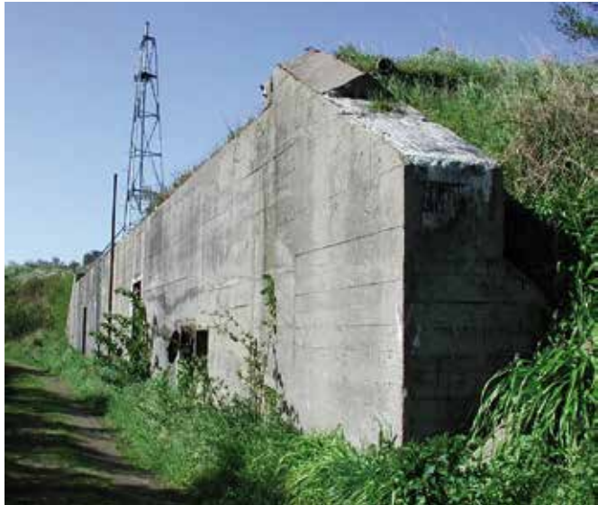
Bunker Hamburg. Foto: G.A. van Geffen.
