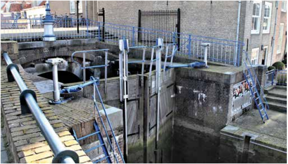
De Monstersche sluis met de buitenvloeddeuren. Rechts de namen en wapens van het bestuur van het hoogheemraadschap van Delfland in 1602. Foto: auteur, 2014.
