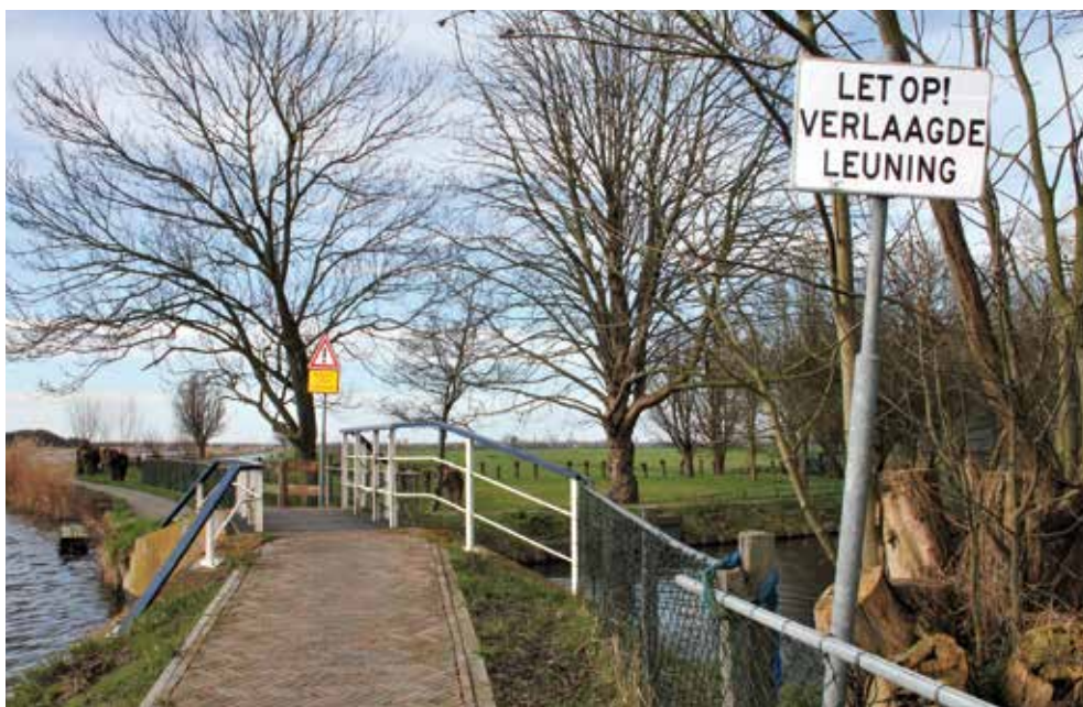
Een bruggetje in het voormalige tracé van het jaagpad langs de Noordvliet. De verlaagde leuning aan de waterkant was er voor de passage van de jaaglijn en vaarboom. Foto: auteur, 2017.
