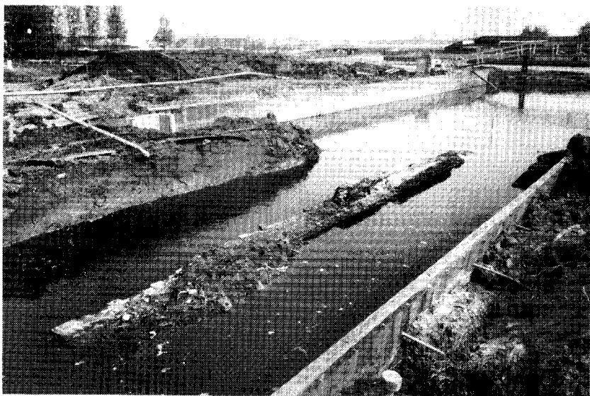
Honselersdijk, Middel Broekweg. De funderingsmuur van de brug is een obstakel in de nieuwe verbrede vaart. (Foto J.C. van Dijk)
