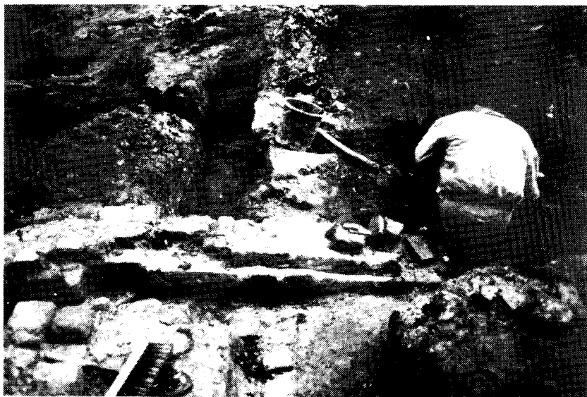
De fundering die gevonden werd aan de 's-Gravenzandse Langestraat.
