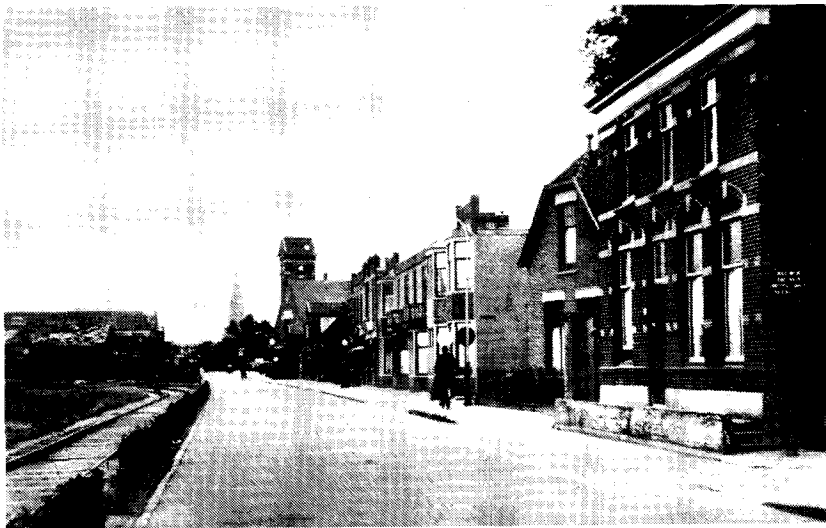
Destijds de toegang naar het Coverin-bedrijf vanaf de Monsterse weg te Poeldijk, op deze foto uit later jaren Slachthuisgade genaamd. (Coll. J.N.M. van Leeuwen, Poeldijk)
